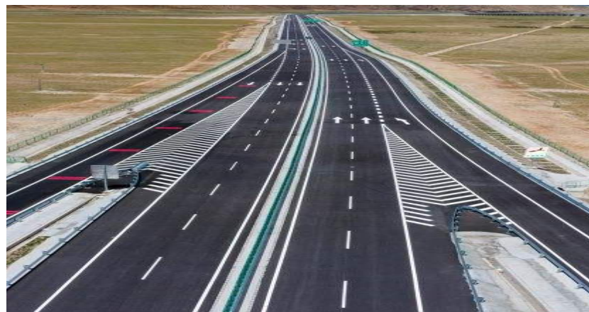
世界海拔最高的高速—那拉高速（平均建设海拔4500 米）
